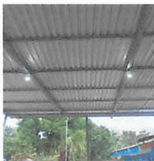
Foto 5: Instalación de bombillas para iluminación de la galera construida.
