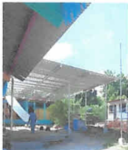
Foto 1: Finalizando de colocar el enlaminado a la galera.
