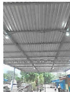
Foto 6: Visualización de iluminación de la galera terminada.
