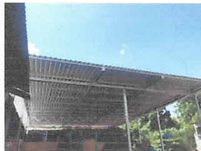
Foto 2: Finalización del techado de lamina de la galera.
