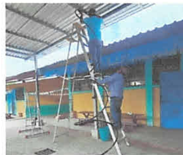
Foto 4: Instalación de corrientes eléctricas para la iluminación de la galera.
